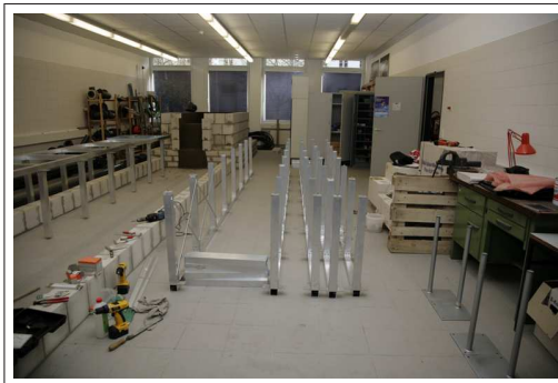
(c) Montage der Tragkonstruktion
