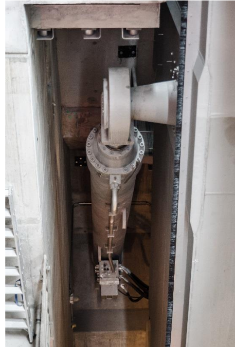
Abbildung 16: Innenraum Pfeiler im aufgeklappten Zustand / Hydraulik des Klappenmechanismus
