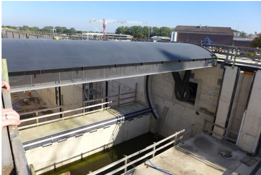
Abbildung 3: Drehsegmenttor am Oberhaupt
