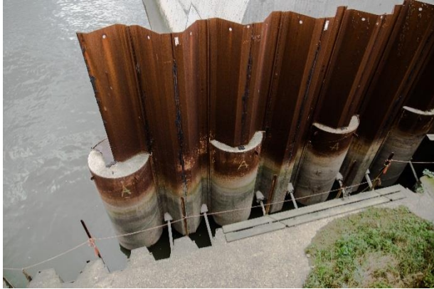
Abbildung 14: Spundwand der ehemaligen Baugrube
