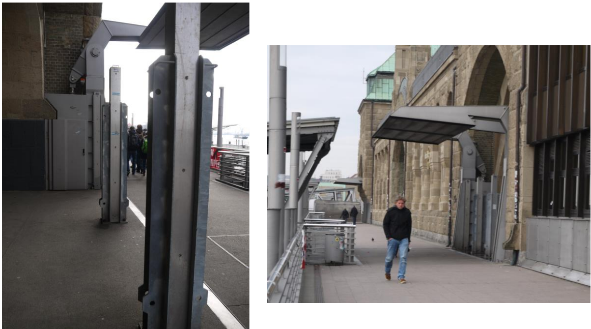
Abbildung 6: Hochwasserschutz Tore an den Landungsbrücken
