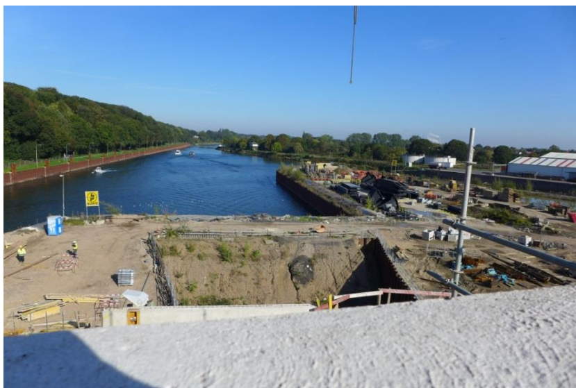
Abbildung 4: Blick von der Schleusenbrücke auf das Unterwasser
