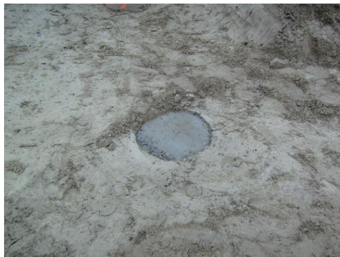
Abbildung 42: Abgezogene CMC-Säulen ohne Kopfplatte
