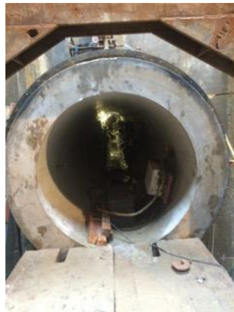
Abbildung 32: Ortsbrust mit verdichtetem Ringspalt
