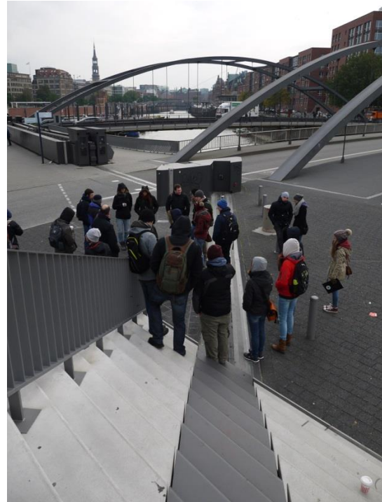
Abbildung 5: Hochwasserschutztor am Baumwall
