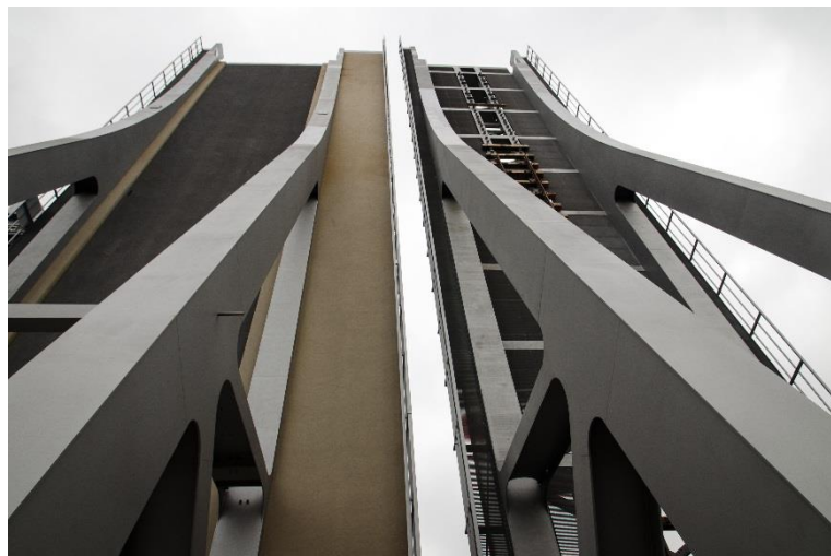
Abbildung 15: Überbau getrennt nach Straßen- und Schienenverkehr
