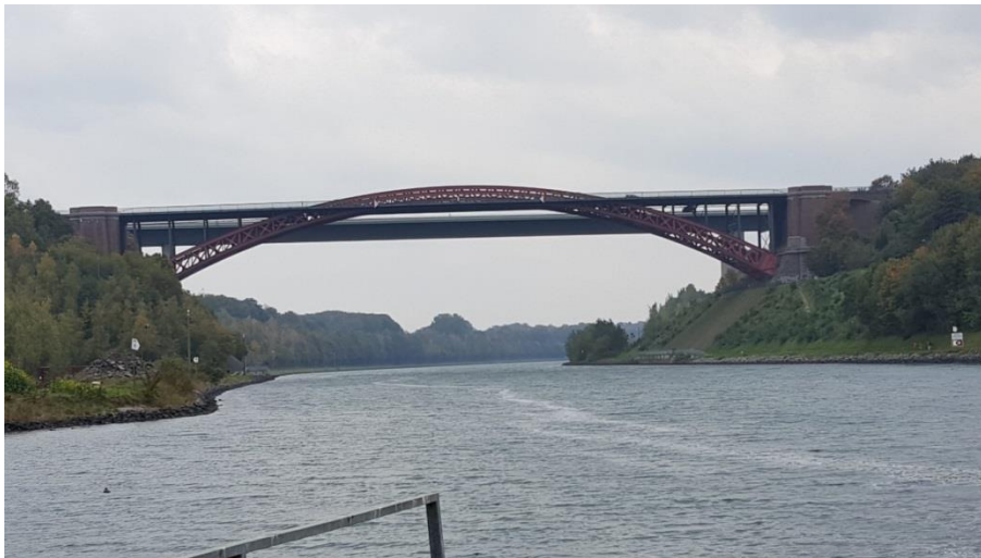
Abbildung 33: Bestehende 1. Levensauer Hochbrücke (Baujahr 1894)
