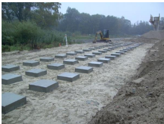
Abbildung 38: Fertige CMC-Säulen mit aufbetonierten Kopfplatten
