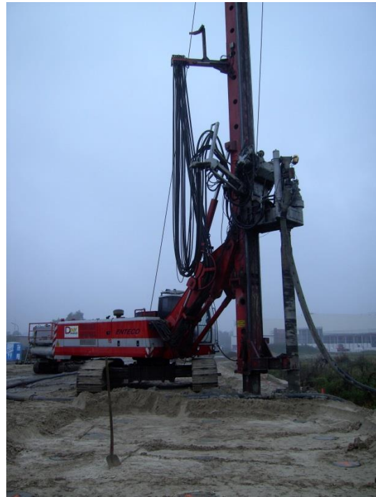
Abbildung 39: Bohrgerät zur Herstellung der CMC-Säulen
