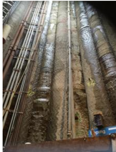
Abbildung 30: Überschnittene Bohrpfahlwand
