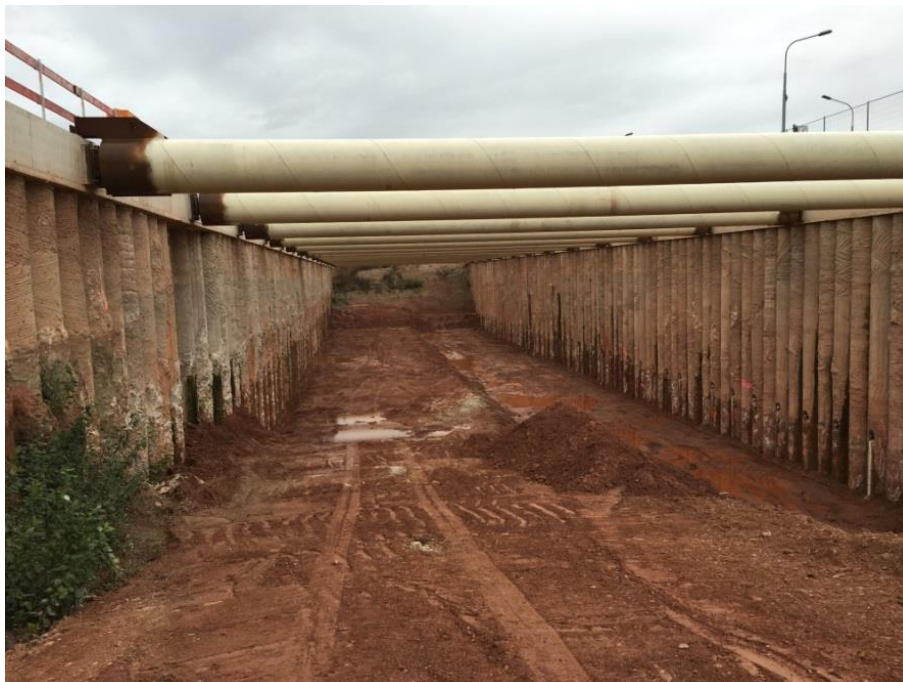
Abbildung 9: Sicherung Schleusenkammer durch Bohrpfehlwand (Foto: H. Aue, A. Bock)
