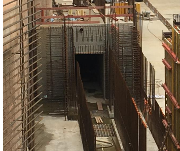
Abbildung 11: Längskanal zum Befüllen (Foto: H. Aue, A. Bock)
