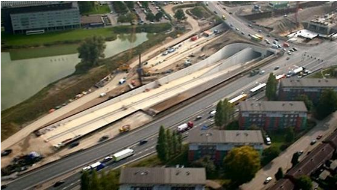
Abbildung 12: Luftbild der Tunneleinfahrt nach Fertigstellung des Rohbaus (Quelle: http://www.ingenieur.de/var/storage/images/media/ingenieur.de/bilder/luftaufnahme-tunneleingang-geusselt/3842421-1-ger-DE/Luftaufnahme-Tunneleingang-bei-Geusselt_image_width_560.jpg )
