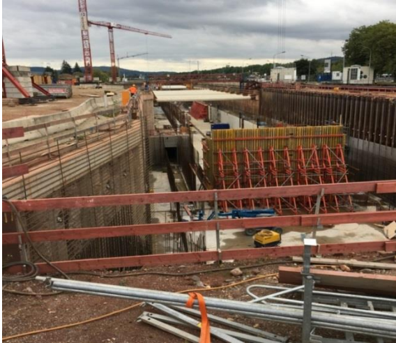
Abbildung 10: Betonieren der Schleusenammer mit den Längskanälen zum Befüllen (Foto: H. Aue, A. Bock)
