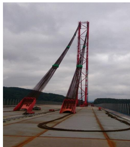
Abbildung 5: Fahrbahn im Rohzustand (Foto: D. Lörpen)
