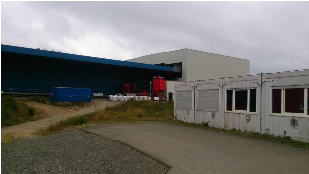
Abbildung 6: Beschichtungshalle (Foto: D. Lörpen)
