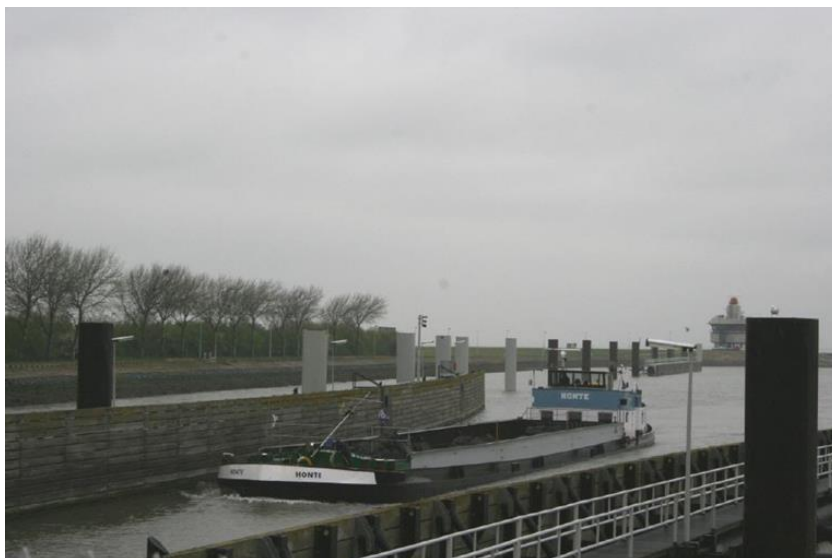
Abbildung 21: Schleuse Terneuzen vor dem Umbau 2016
