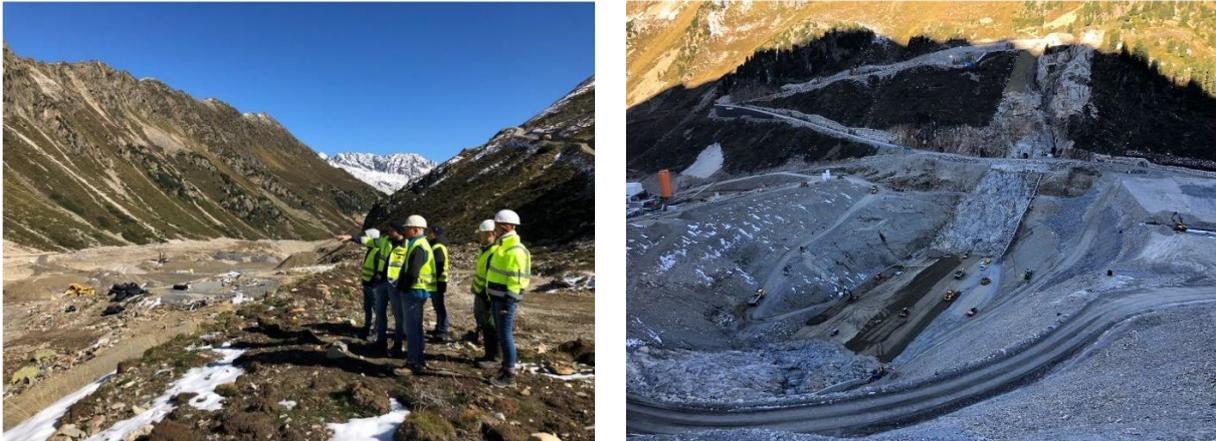
Abbildung 4-2 Abbaubereich des Schüttmaterials (links), Herstellung des Damms (rechts)
