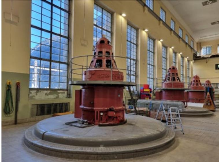
Abbildung 2-2 Kraftwerk Handeck 1 Maschinenhaus mit Drehstromgeneratoren
