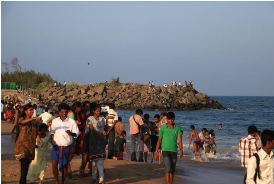
Abbildung 28 – Wellenbrecher zum Schutz des Küstentempels
