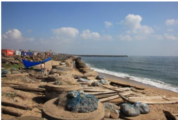
Abbildung 20 – Uferbefestigung und Buhne im Norden des Hafens in Chennai
