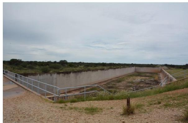
Abbildung 32 Überlaufschwelle und Tosbecken der Hochwasserentlastung
