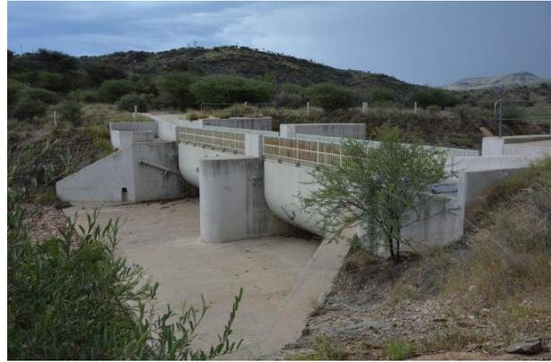
Abbildung 6 Hochwasserentlastungsanlage am Avis-Damm
