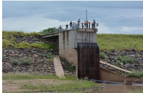
Abbildung 30 Entnahmeturm des Omatako-Damms
