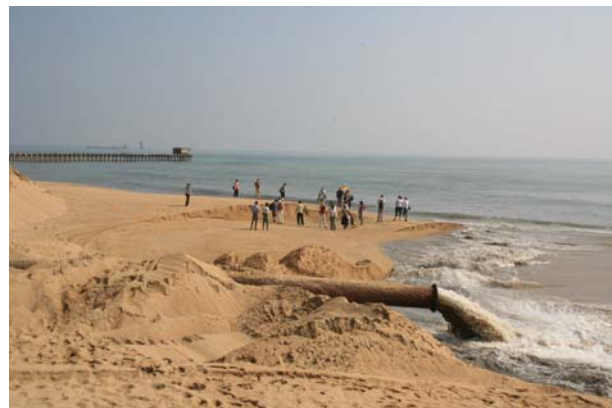
Abbildung 5 – Sandumlagerung in Ennore Creek
