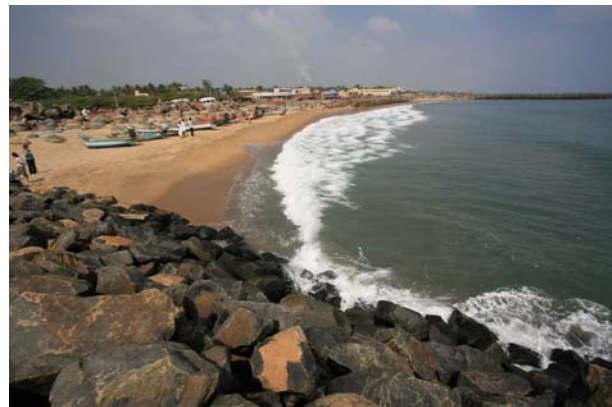
Abbildung 7 – Durch die Errichtung einer Buhne wieder angelandeter Strand eines kleinen Fischerdorfs im Norden von Chennai
