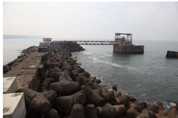
Abb. 11: Wellenbrecher/Wellenkraftwerk in Kovalam
