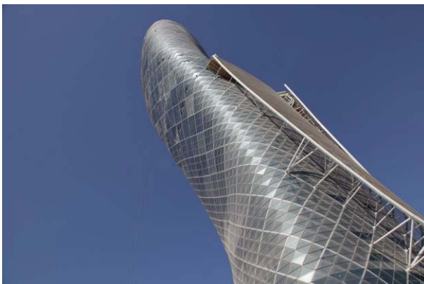
Abb. 3: Hochbaustelle in Abu Dhabi
