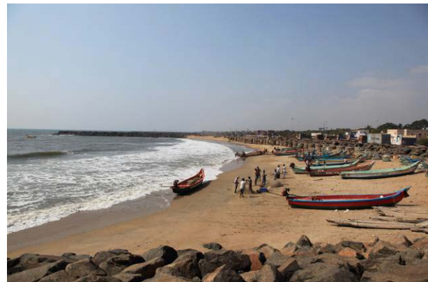
Abb. 6: Schutzmaßnahmen nördlich des Hafens
