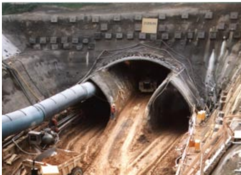
Tunnel Wandersmann Nord - Ulmenbauweise
