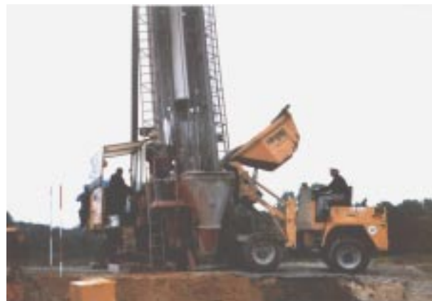
Verfüllung eines Franki-Rammpfahles
