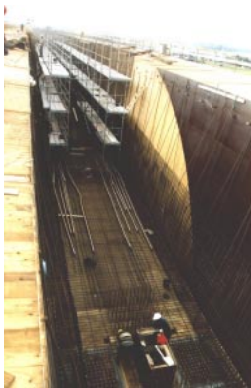
Schalung der Brücke Mainquerung
