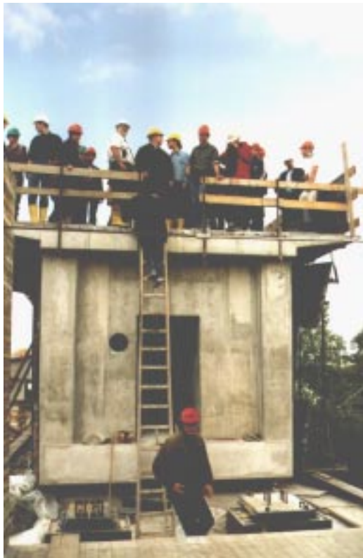
Hohlkastenprofil der Ticonabrücke
