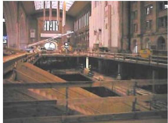
Abb. 10: Umbau Hauptbahnhof Leipzig
