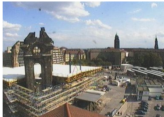
Abb. 17: Gerüst zur Rekonstruktion der Frauenkirche
