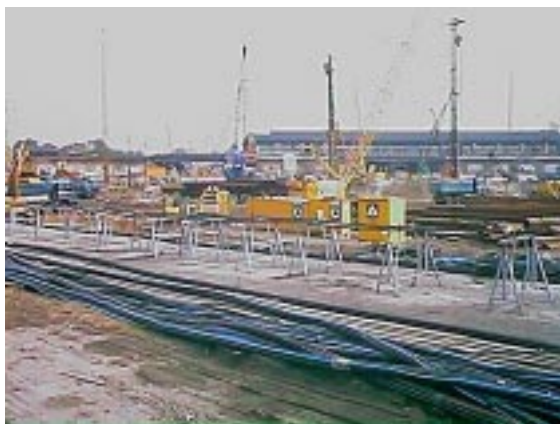
Abb. 1: Baustelleneinrichtung am Lehrter Bahnhof
