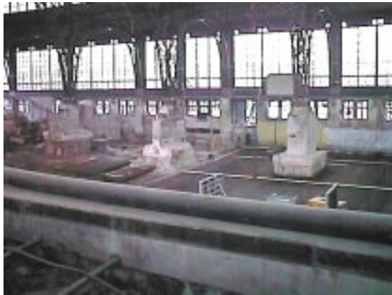
Abb. 11: Freigelegte, unterfangene Fundamente
