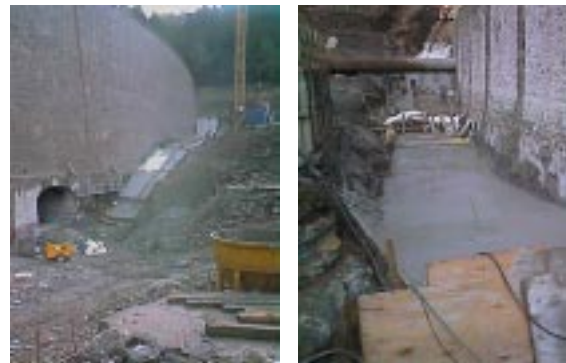
Abb. 13 und 14: Mauerfuß im Staubereich
