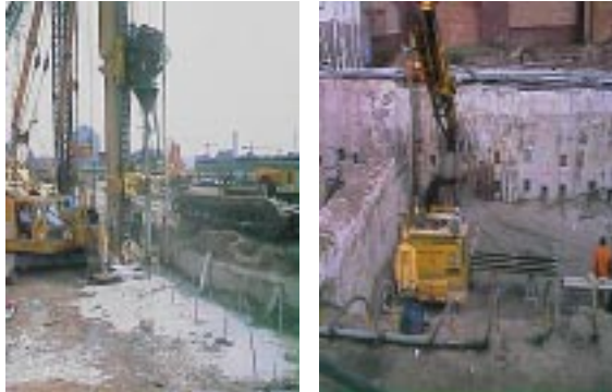
Abb. 4 und 5: Injektion der Weichgelsohle und Rückverankerung der Schlitzwand
