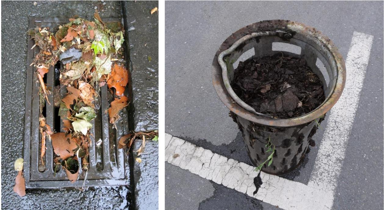
**Abbildung 1:** Verlegter Straßenablauf-Aufsatz (links) und gefüllter Schlammeimer (rechts)
