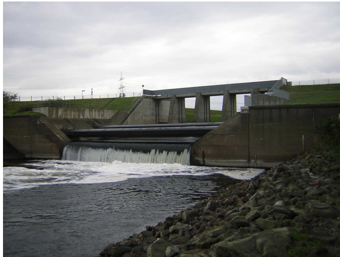
Abbildung 11.1: Emschermündung (Blick auf das Absturzbauwerk)
