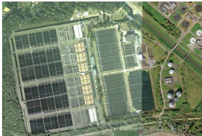
Abbildung 10.3: Klärwerk Emschermündung, Quelle: google.maps
