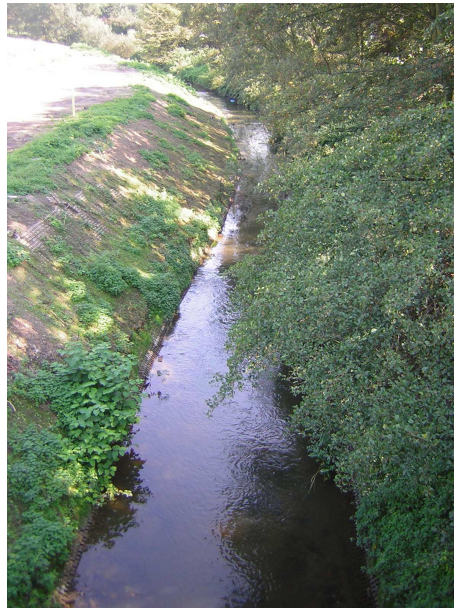
Abbildung 8.3: Angermündung (Blick gegen Fließrichtung)
