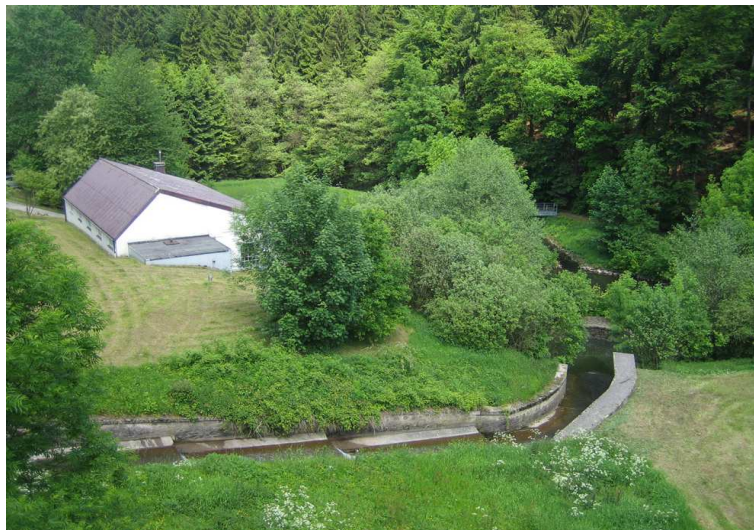
Abbildung 3.6: HW-Entlastung, Tosbecken und Trinkwasseraufbereitungsgebäude
