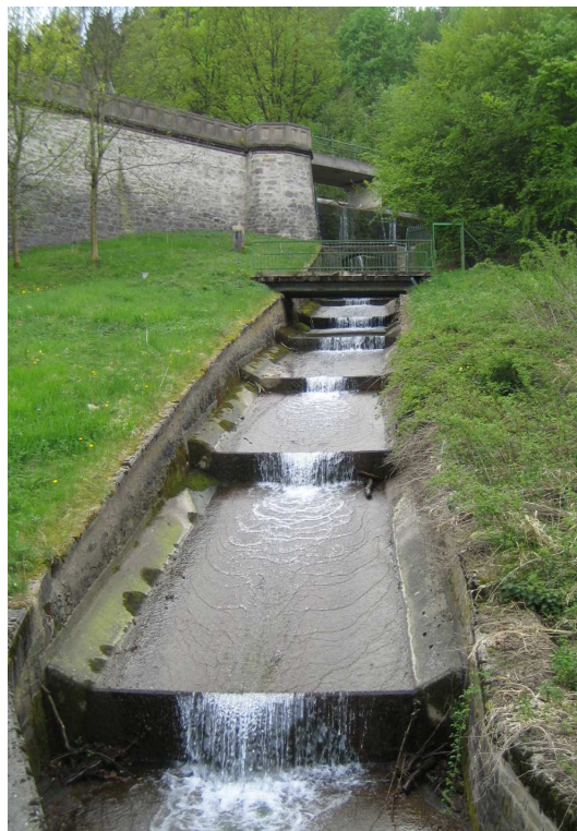
Abbildung 3.4: Hochwasserentlastung
