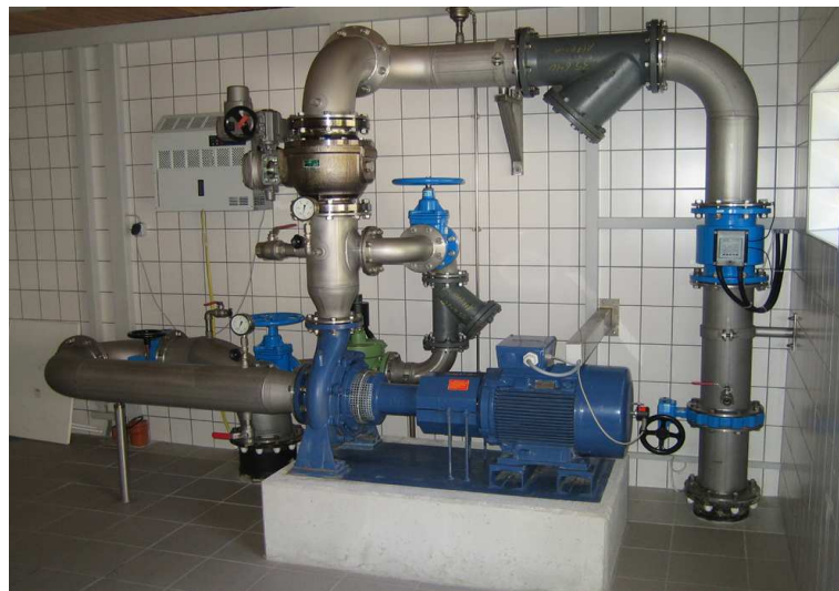
Abbildung 8.3: Turbinenanlage der Fuelbecke Talsperre
