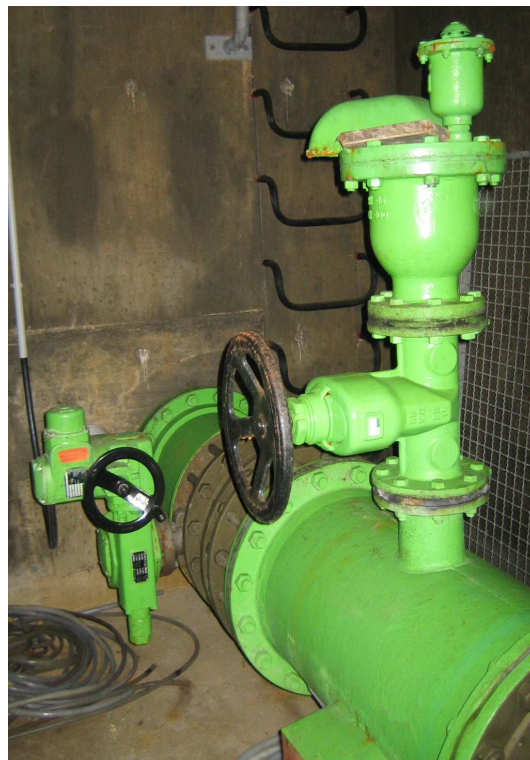
Abbildung 3.5: Grundablassleitung – wasserseitig
