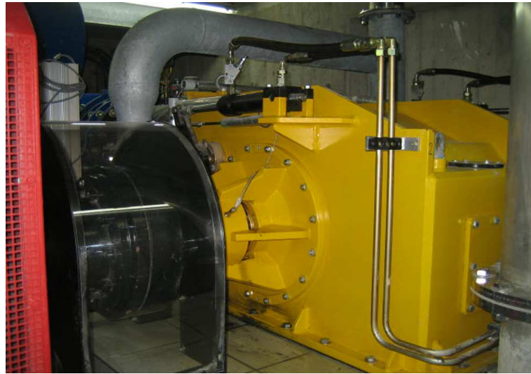
Abbildung 8.1: Durchströmturbine an der Ennepetalsperre
